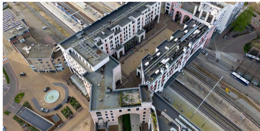
Referentie verhoogd maaiveld: Station Heerlen (foto: Remke Luitjes)
