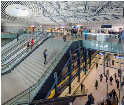
Referentie spoortunnel met station op mezzanine: spoortunnel Delft (foto: ImagineBV)
